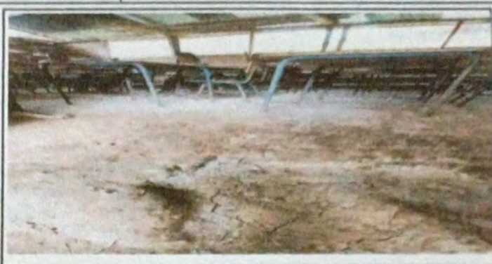
Foto 2: Se puede observar que el piso esta en mal estado en todas las aulas.
